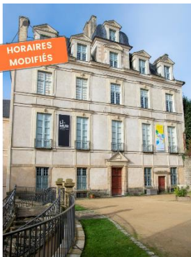
Hôtel de Limur, 31 rue Thiers à Vannes ©F. Le Divenah
